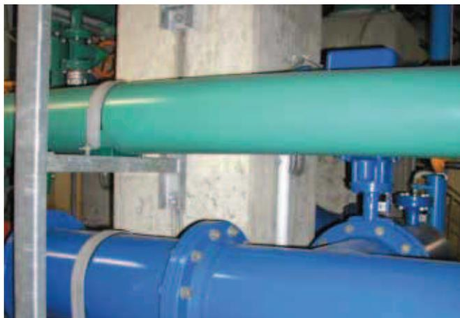
Rohrleitungsunterstützung an senkrechter HZA-Schiene
