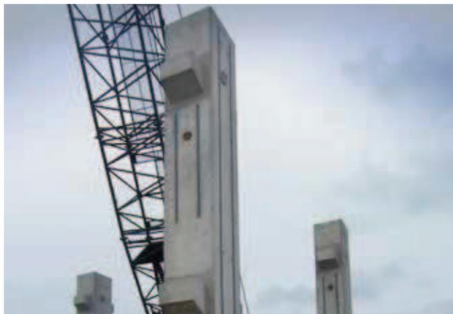
Vertikale Schienen für Anbauteile an Stützen
